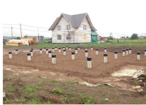
специалистов после выезда непосредственно на участок строительства. На месте проводится инженерно-геологические изыскания, представляющие собой исследование почвы, в процессе которого определяются характеристики и свойства грунта. Проводится пробное бурение, которое позволит выяснить величину заглубления свай.
